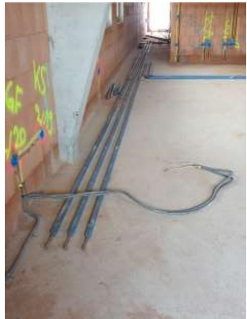
Für die Fußbodenheizung musste der komplette Sozialtrakt saubergemacht werden, damit das Bitumenband, das zusätzlich als Isolierschicht dient, verlegt werden konnte.
