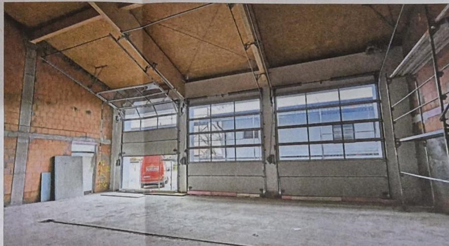
Die Bauarbeiten am Feuerwehrhaus gehen voran. Es wird geheizt, so dass demnächst die Putzarbeiten im Innenraum begonnen werden können.
