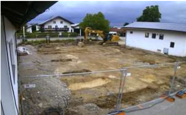
Aushub der Baugrube für Bodenplatte am 24.05.2024
