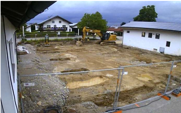
Aushub der Baugrube für Bodenplatte am 24.05.2024
